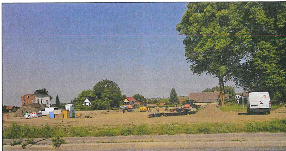
Die Pfahlgründungen für den DRK-Neubau auf dem Gelände der alten Poliklinik sind abgeschlossen.
