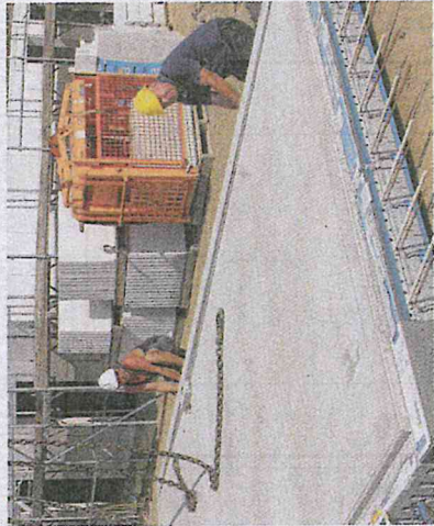
Fred Hoffmeier (l.) und André Stiebke von der Brüssower Baufirma Eich GmbH befestigen eine 13-Tonnen schwere Wandplatte am Kranhaken.
