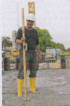
Der Polier André Stübke justiert mit Lasertechnik die Höhe des Betons.
