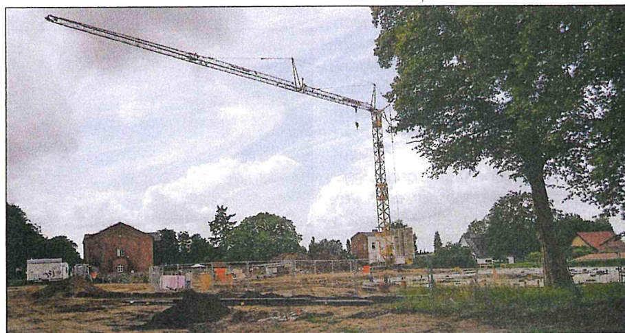
Seit dem 21. Juni steht nun auch der Baukran und die Rohbauarbeiten haben begonnen. Fotos: D. Vallentin
