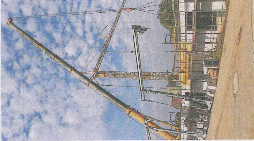
Fred Hoffmeier (l.) und André Stiebke von der Brüssower Baufirma Eich GmbH befestigen eine 13-Tonnen schwere Wandplatte am Kranhaken.
