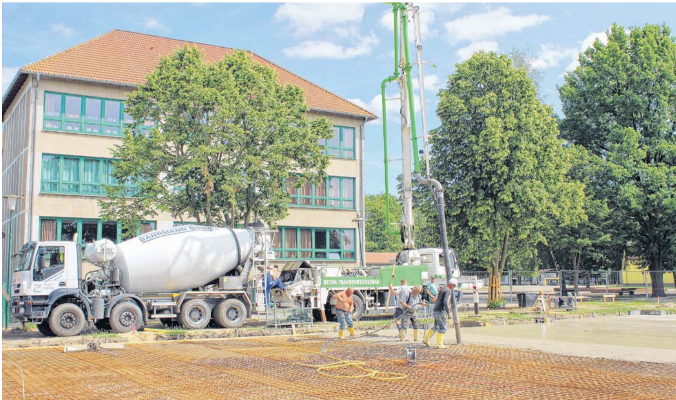
15 Zementmischfahrzeuge waren 12 Stunden lang im Einsatz, um 400 Kubikmeter Beton für die Grundplatte der neuen Löcknitzer Grundschule zur Verfügung zu stellen. FOTOS: RITA NITSCH
