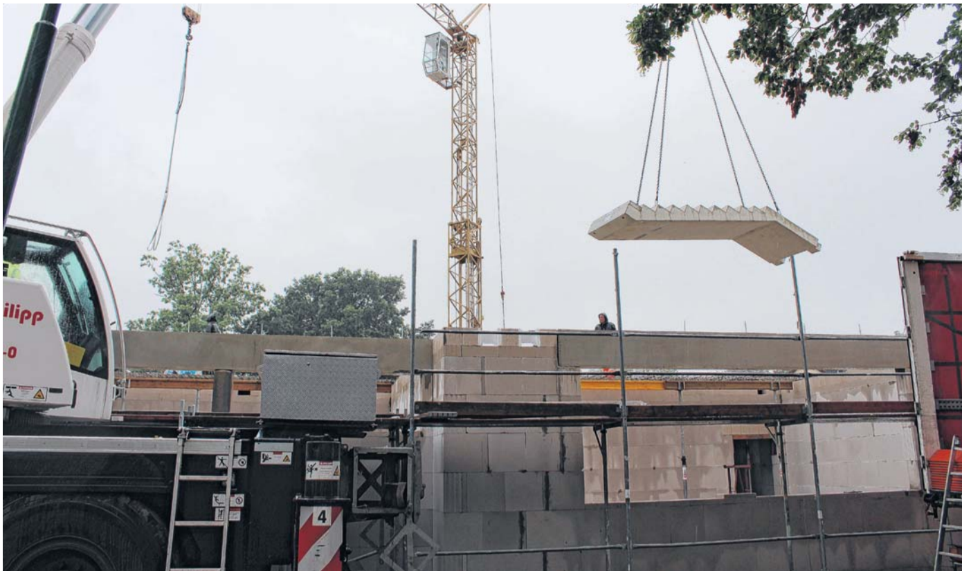
Trotz grauer Wolken und Dauerregen: Die Arbeiten auf der Baustelle für die Löcknitzer Grundschule gehen weiter.
